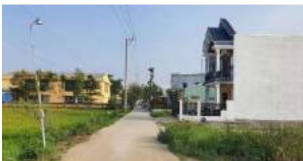
Đường số 4 kết nối phía Tây dự án với ĐT609
