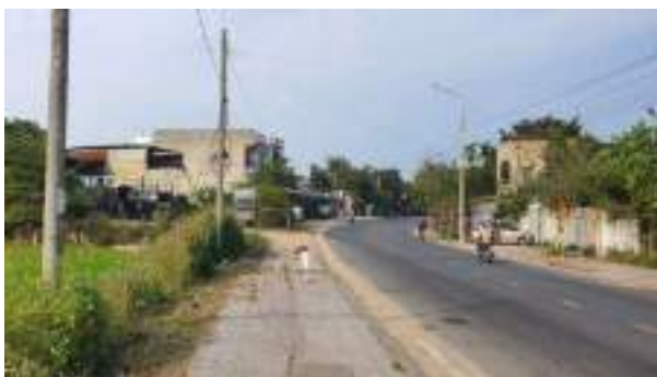
Đường ĐT609 phía Đông Nam dự án
